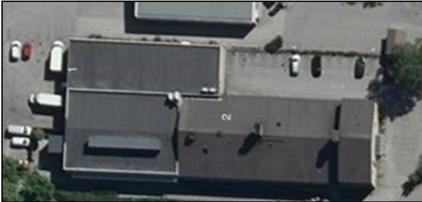
Figur 16, Flygfoto över fastigheten Boländerna 9:1, bildkälla eniro.se
