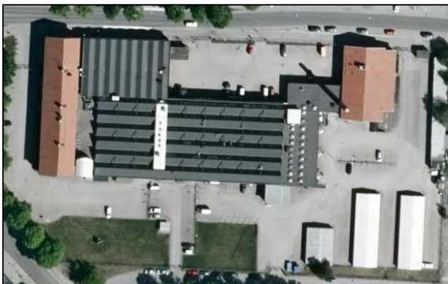
Figur 15, Flygfoto över fastigheten Boländerna 8:1, bildkälla eniro.se
