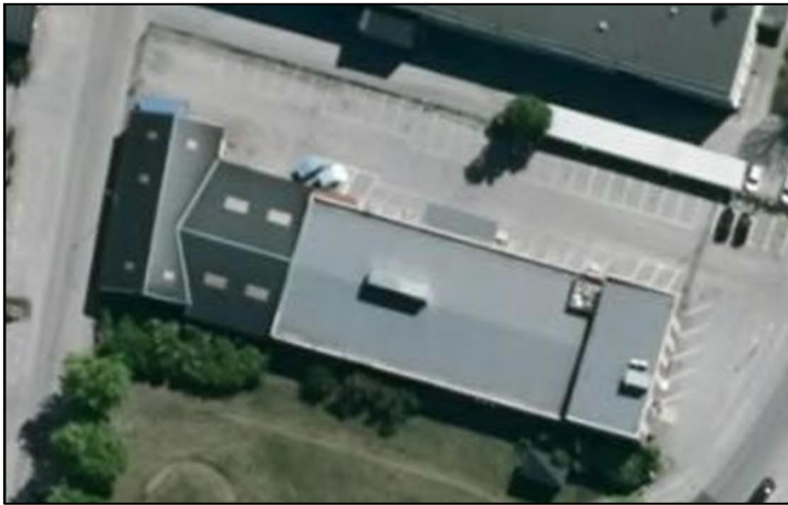
Figur 20, Flygfoto över fastigheten Boländerna 11:1, bildkälla eniro.se
