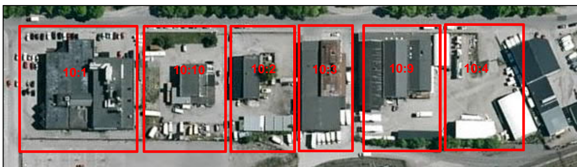
Figur 18, Flygfoto över fastigheten Boländerna 10:1, 10:2, 10:3, 10:4, 10:9, 10:10, bildkälla eniro.se
