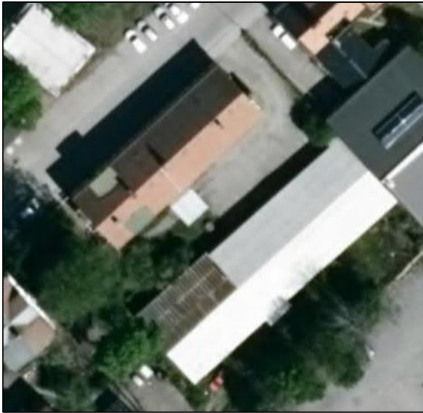
Figur 12, Flygfoto över fastigheten Boländerna 7:2, bildkälla eniro.se
