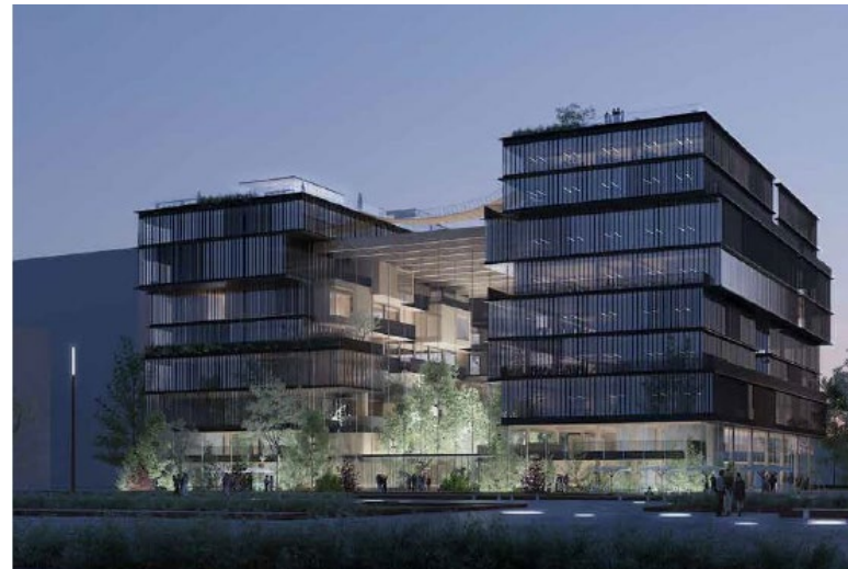
Boländerna 10:1 på Säbygatan 5 och Östunagatan 2, vy från Bergsbrunnplan
