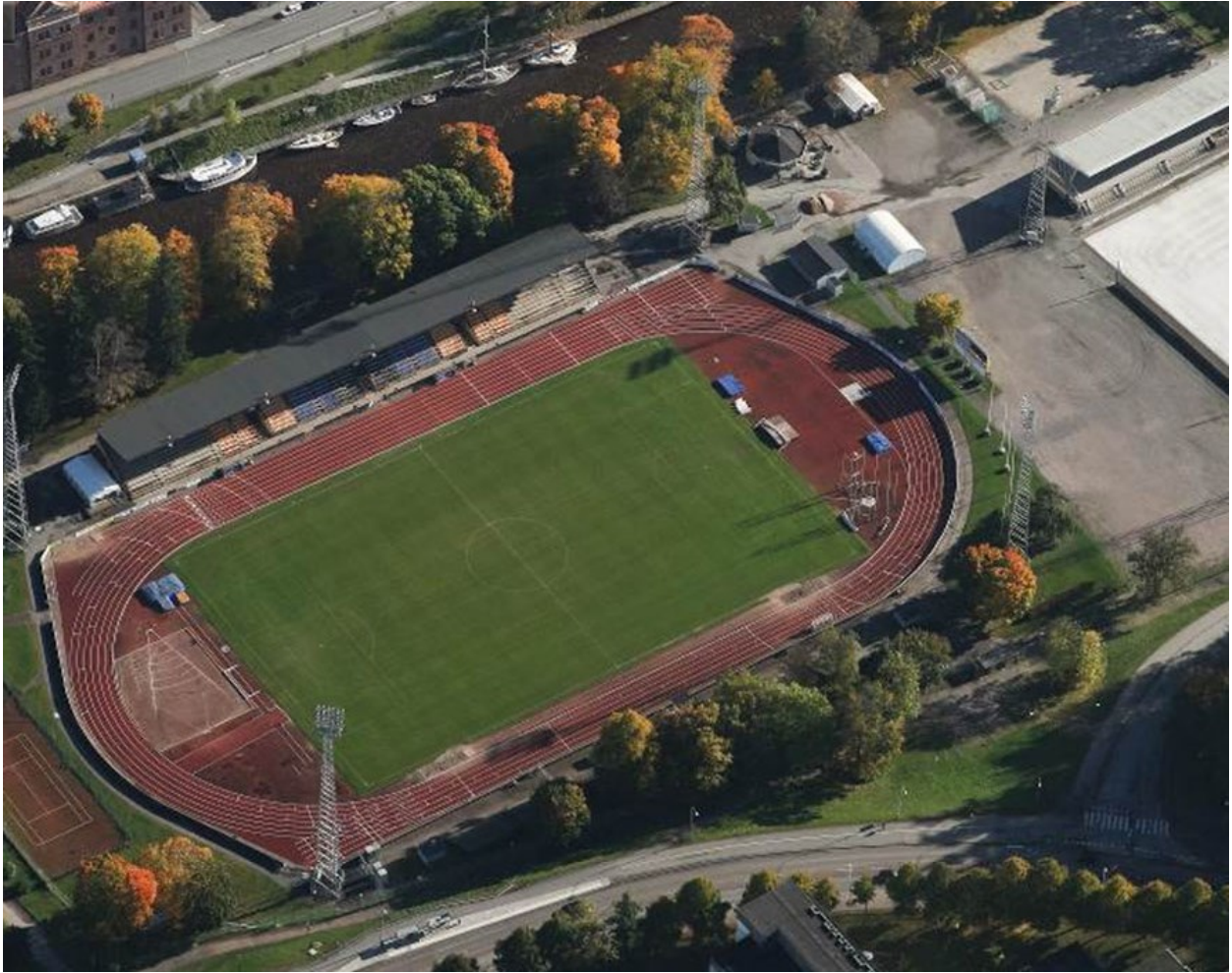
Flygfotot visar befintlig fotboll- och friidrottsarena.
