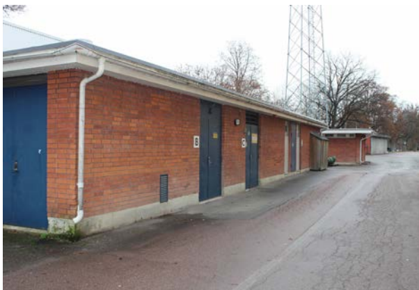
Fasad mot väster, vy från norr med hus 12 i bakgrunden
