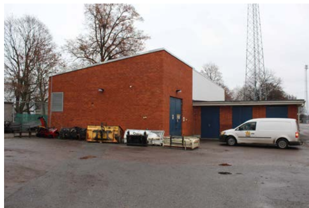
Vy från norr med den högre maskinhallen till vänster.
