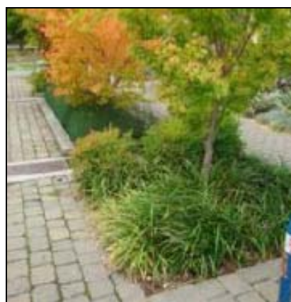
Exempel på hur parkering och köryta avvattnas mot växtbäddar. (Bilder från dagvattenutredningen).
