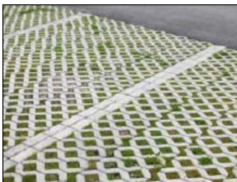
Exempel på genomsläppligt material på parkeringsyta samt utformning av ett makadamdike. (Bilder från dagvattenutredningen)
