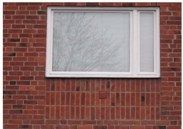
Fönstersättning med fönsterbröstningens karakteristiska murning med tegel på högkant. Resten av fasaden är murad i munkförband.
