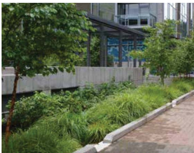
Figur 7: Parkering och köryta avvattnas mot växtbäddar.
