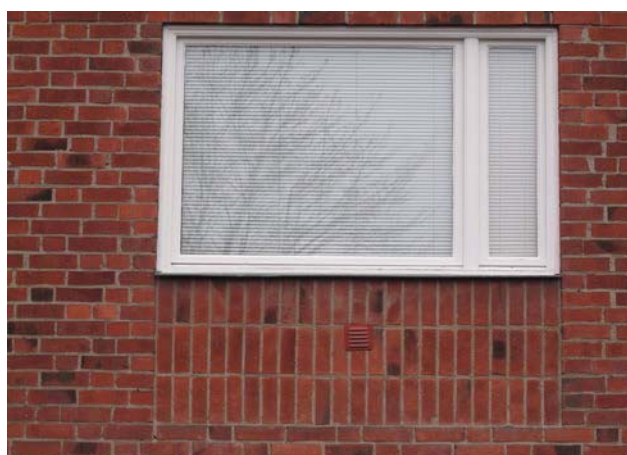
Fönstersättning med fönsterbröstningens karakteristiska murning med tegel på högkant. Resten av fasaden är murad i munkförband.
