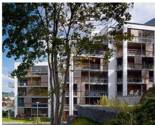
Bilderna till höger är exempel på hur trä kan integreras i fasaden (Sweco Architects, fotograf: Felix Gerlach samt Bert Leandersson).
