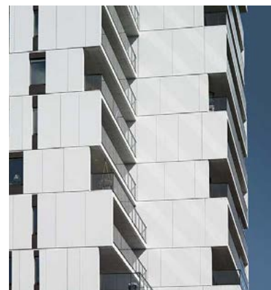
3. EXEMPEL PÅ OMHÄNDERTAGNA ELEMENTSKARVAR
