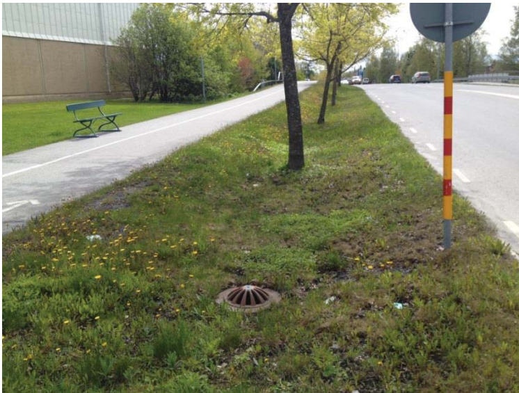
Figur 8. Exempel på svackdike intill hårdgjord yta
