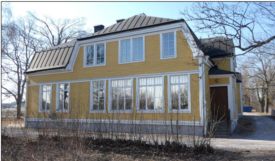
Vaksala kyrkskola sedd från sydost.
