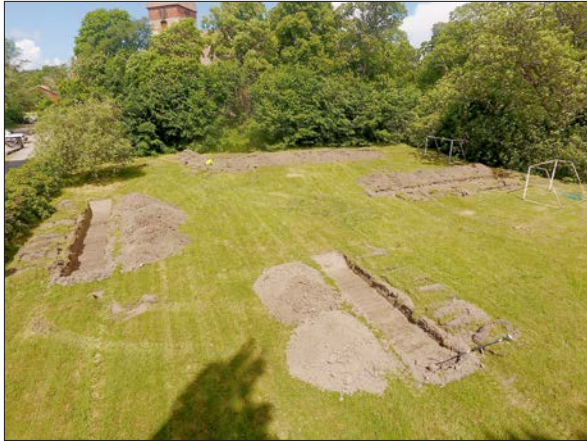
Figur 13. Schakt i undersökningsområdets nordvästra del. Härden ligger i schaktet längst bort i bild. På bilden saknas schakt 19. Foto från söder.
