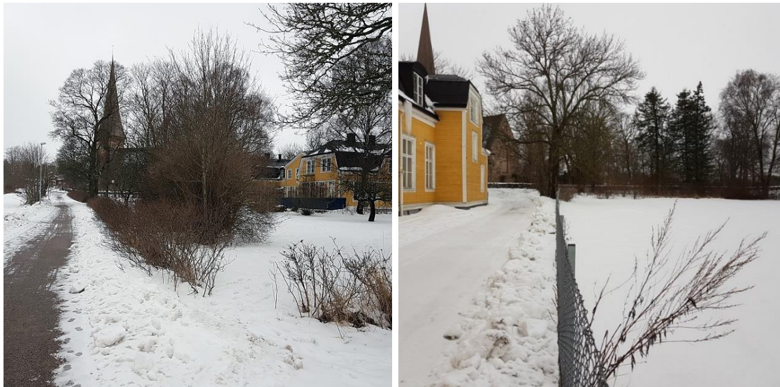
Figur 7. Grunt dike väst om byggnad (tv.). Avsaknad av dike på östra sidan mot kyrkogårdens mark (t.h.). Foto: Tyréns AB.
