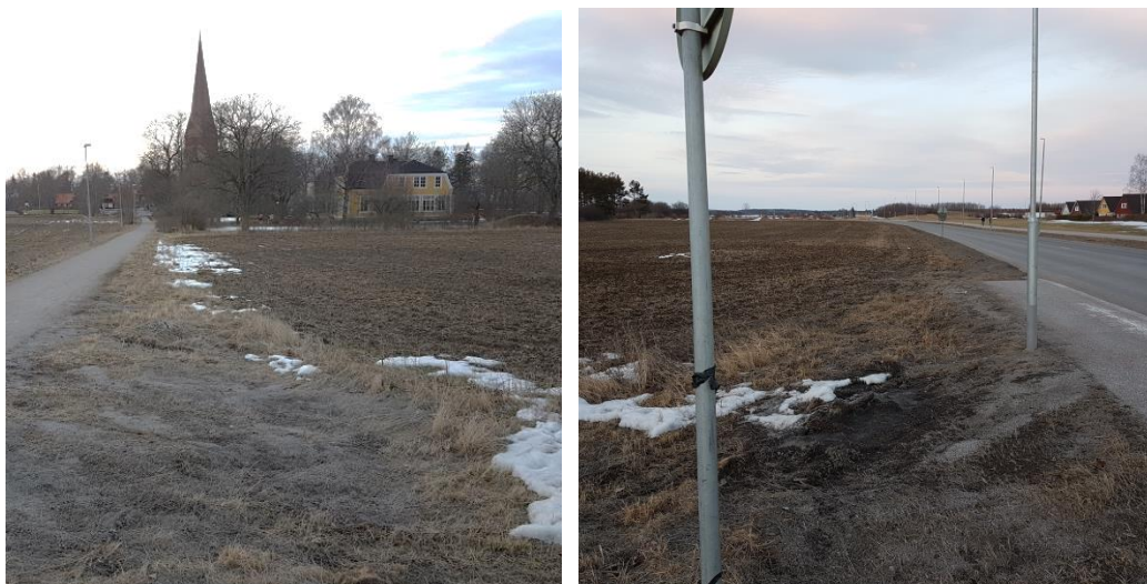
Figur 8. Avsaknad av diken runt planområdet, men något upphöjda vägar. Foto: Tyréns AB.
