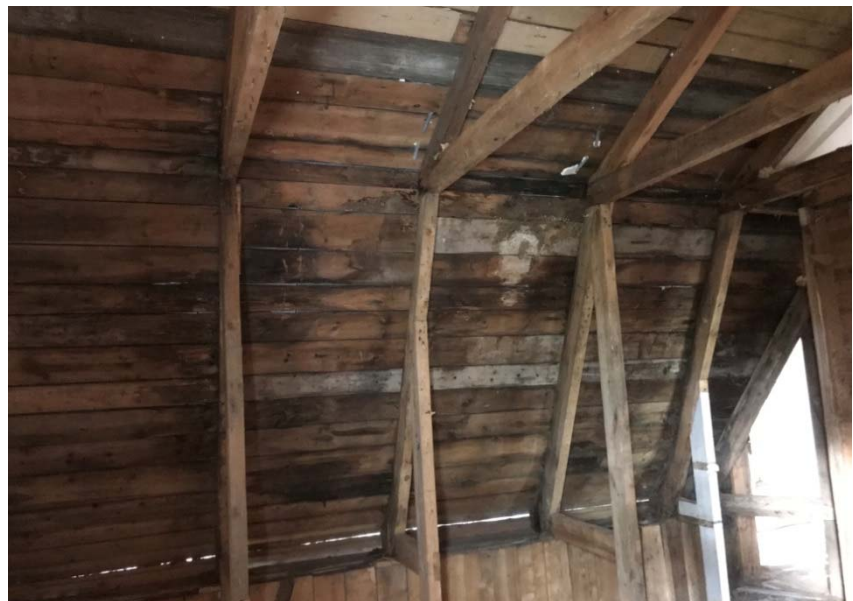
Figur 7. Fuktskadad råspont och stomme i behov av utbyte.
