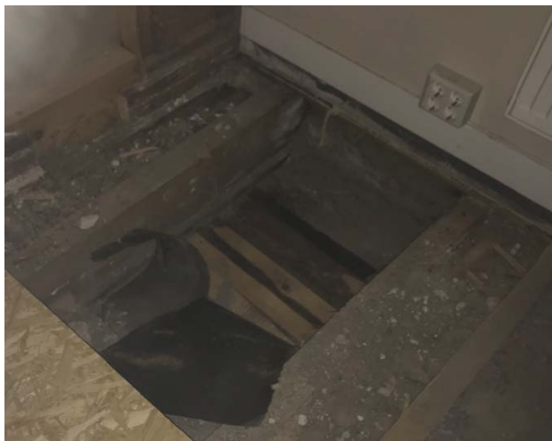
Figur 9. Golvbjälklag med direkt upplag mot oisolerad grundmur i fasad.
