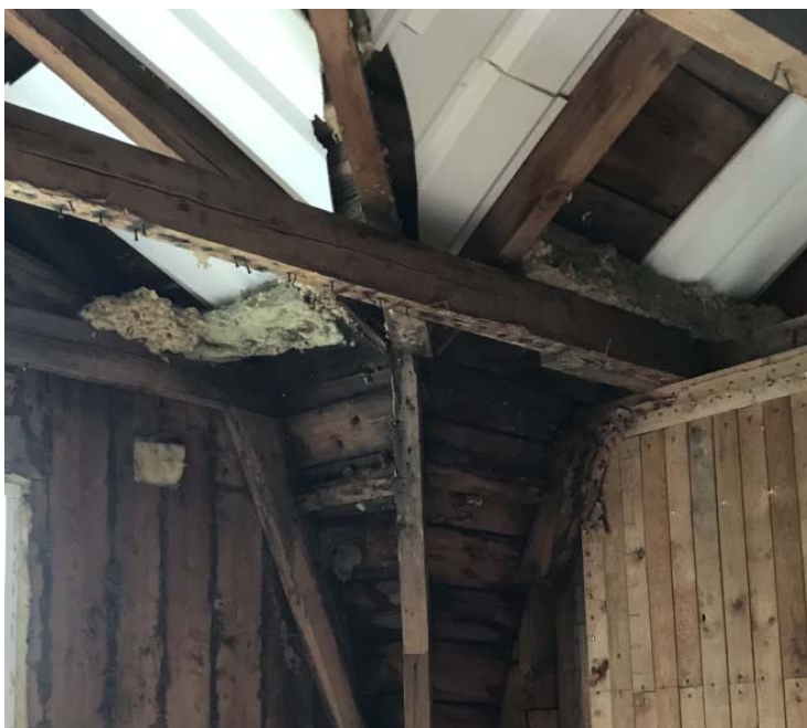
Figur 5. Allvarligt fuktskadad trästomme vid takstolsupplag.
