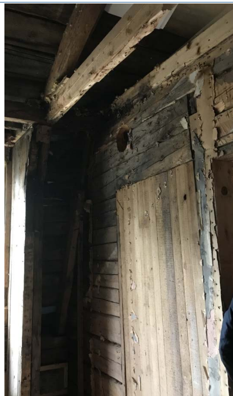
Figur 8. Befintlig trästomme i innervägg som måste saneras eller bytas ut.
