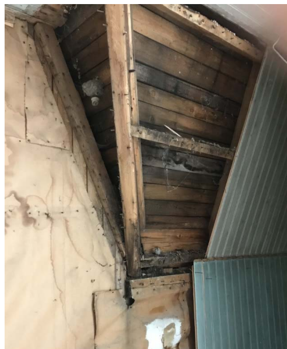
Figur 2. Fuktskadad stomme och råspont bakom invändig panel.
