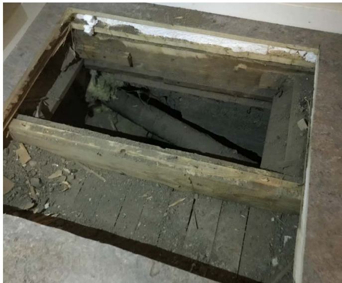
Figur 6. Inspektionsöppning i bottenbjälklag.
