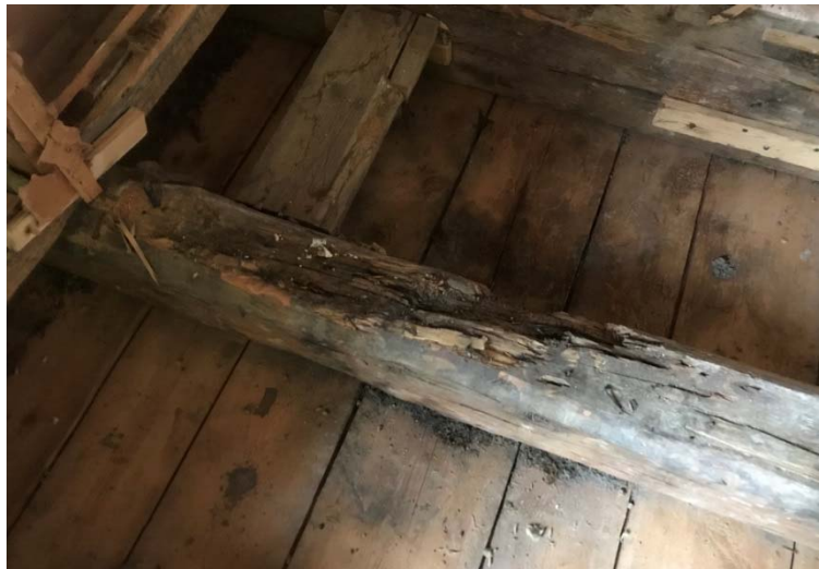
Figur 4. Fuktskadad golvbjälke med nedsatt bärrighet.
