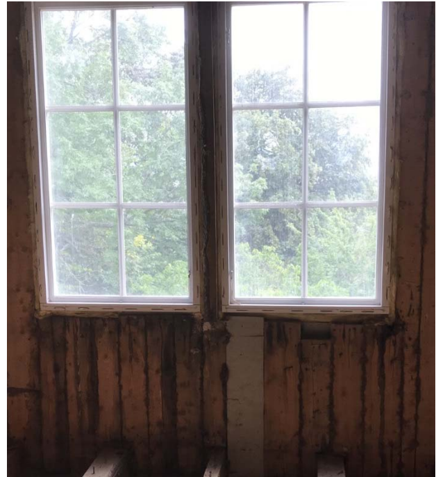
Figur 3. Mikrobiellt angripen och fuktskadad plankstomme i yttervägg.
