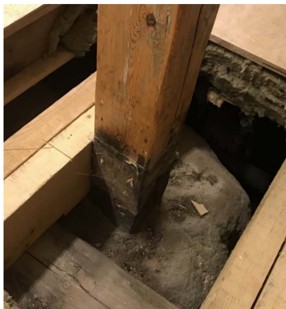
Figur 1. Fuktskadad pelarfot på grundmur av sten.
