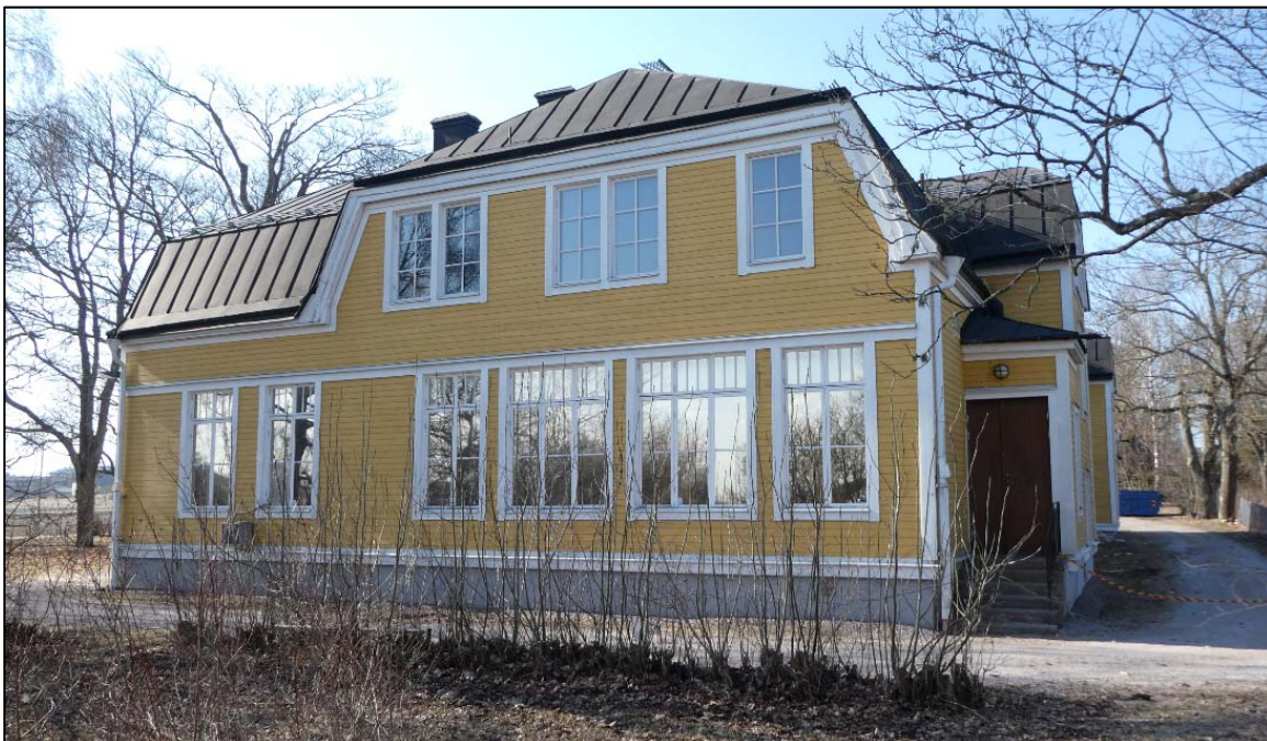
Vaksala kyrkskola sedd från sydost.
