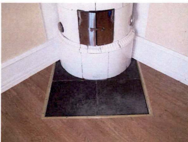
Kakelugn i rum 13 från omkring år 1900. Gammal eldstadsplan av kalkstensplattor.
