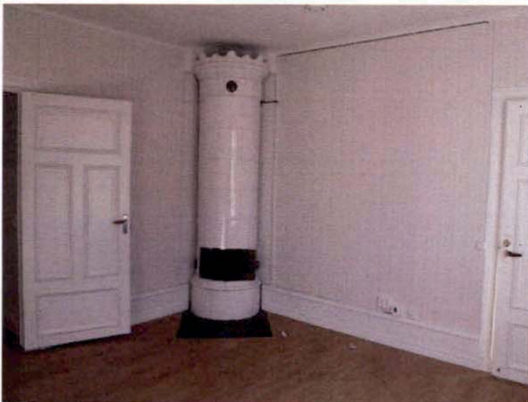
Kammaren, rum 11, med kachelugn från omkring år 1900. Äldre dörrar till köket, t.h., och rum 12, t.v. Sockelpanel från 1880-talet.
