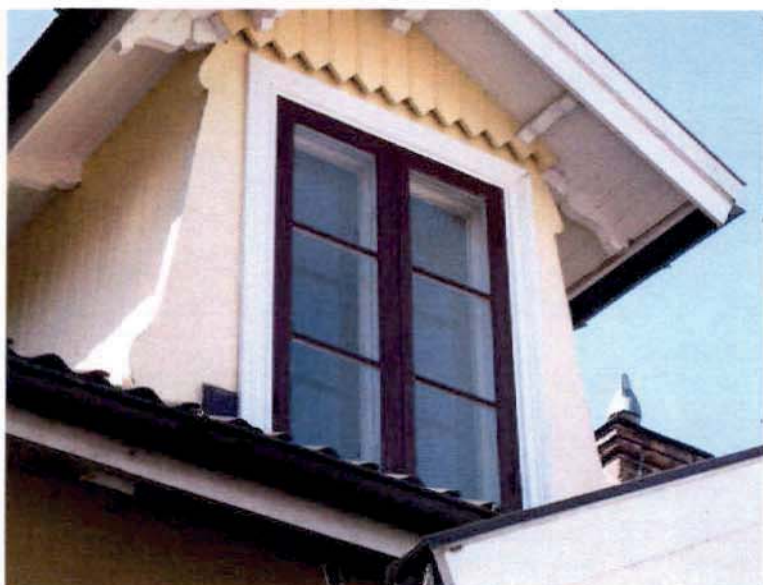
Takkupan med dekorativt utformad panel och profilerade taktassar. Ursprungliga fönstersnickerier.
