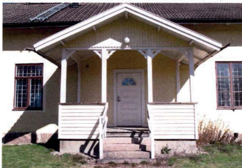
Verandan framför entrén till bostadsdelen mot söder. Grunden är omgjuten i betong. Trappan av granit är äldre.
