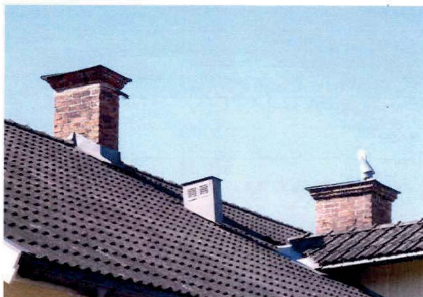
Skorstenarna har bevarat sin traditionella utformning med profilerade krön och klamrade plåtöverbeslag.
