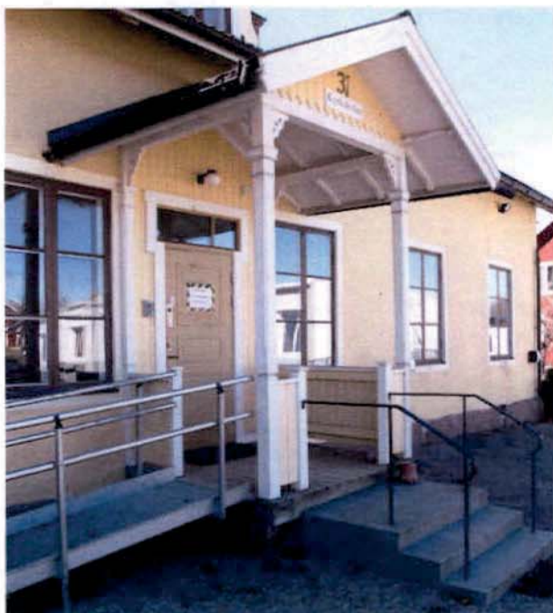
Verandan framför entrén mot norr har på senare år försetts med en ramp av metall. Trappan i betong med klinkersteg är också tillkommen på senare år. Verandans snickeridetaljer är delvis ursprungliga.
