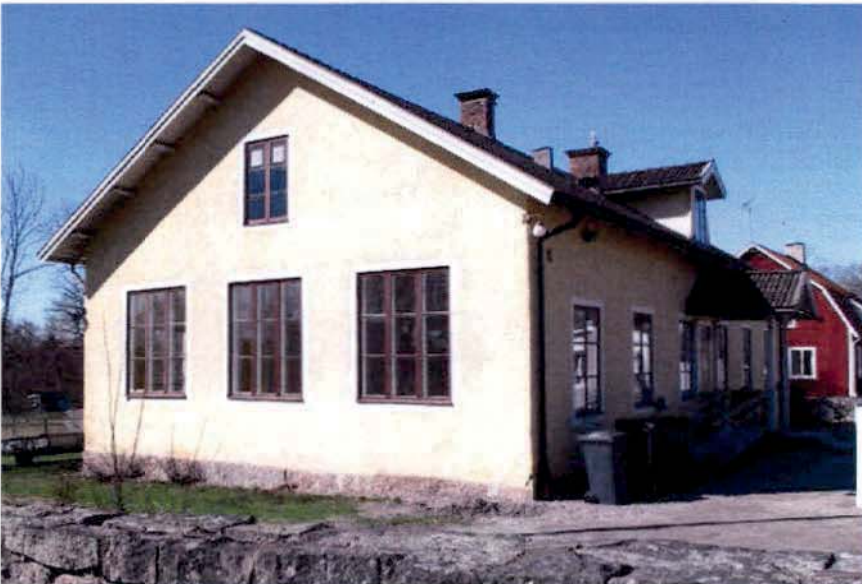
Östra gaveln med de stora fönstren till gamla skolsalen.
