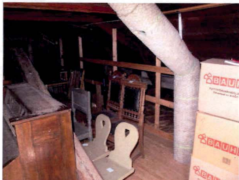
Foto från vindsutrymmet ovanför den gamla skolsalen. Här har en del äldre möbler och en tramporgel magasinrats.
