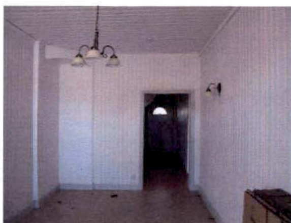
Rum 1. I inre hörnet till vänster finns en putsad vitmålad mur där det tidigare stått en eldstad.
