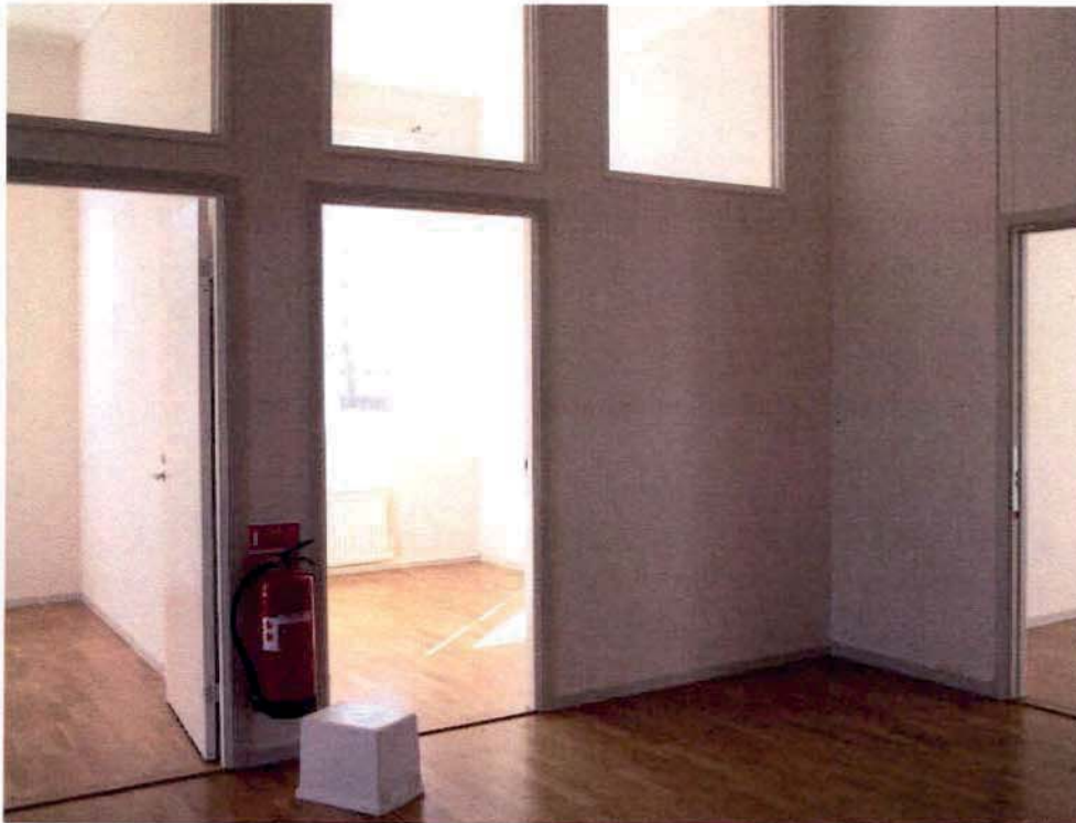
Den f.d. skolsalen har delats in i mindre rum med lättväggar. Parkettgolvet har tillkommit vid en sentida ombyggnad.
