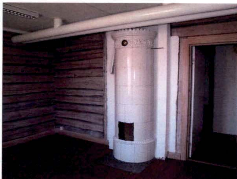
Gavelkammaren på vinden innanför västra gaveln. Här har timmerväggarna frilagts. Kakelugnen hör sannolikt till husets ursprungliga inredning.
