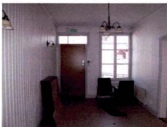
Rum 1. Äldre pärlspontpanel på väggarna. Ursprungliga fönsterbågar mot norr. Dörren är en sentida fabrikslackerad dörr.
