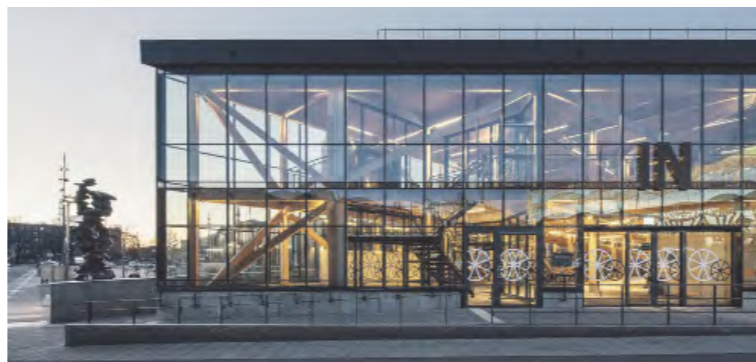
Dagens cykelparkeringshus (källa: Tengbom arkitekter)
